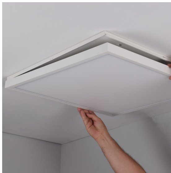
Ramen med LED-plattan fälls upp och hakas fast i överdelen.
