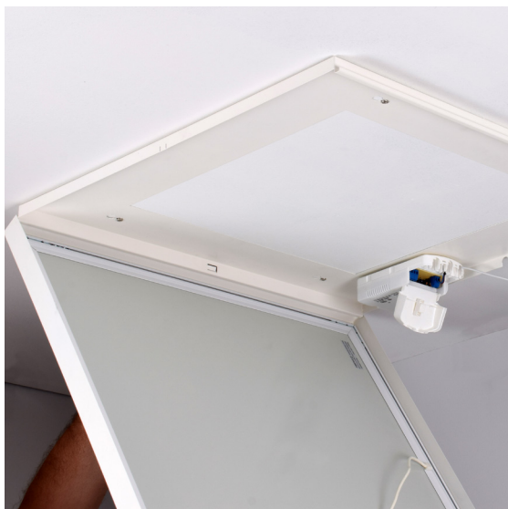
...som hängs på överdelen. Armaturen ansluts till drivaren.
