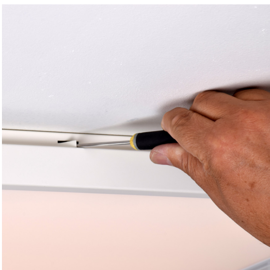
Om behov finns att låsa ramen mot överdelen, kan låsvinklarna fällas ut från överdelen.
